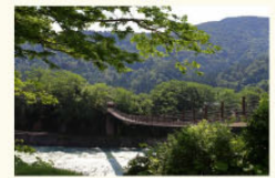
⑨であい橋 DEAIBASHI Bridge
